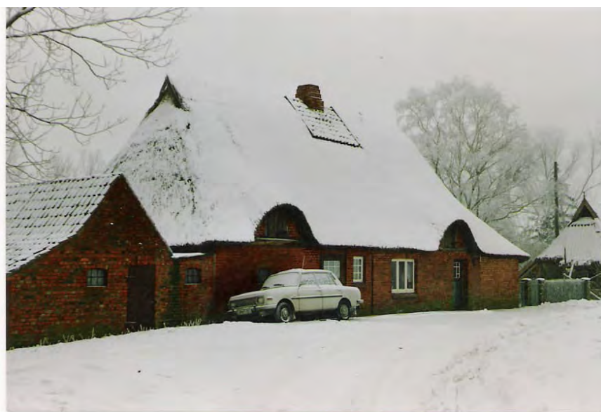
Das winterliche Timkenberger Haus im Jahre 1990. Teerdecke wurde im Jahr 2006 im Rahmen der Deichsanierung auf den Deich gebracht.
