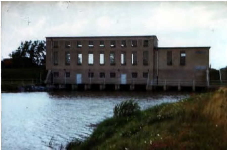
Das Pumpschöpfwerk Niendorf (Quelle: Dieter Greve)
